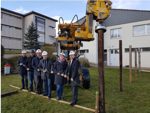
Am 1. März erfolgte der Spatenstich. Baubeginn: 6. März 2017.
