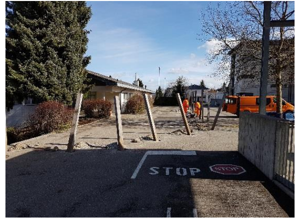
Die Baufirma bereitet die Absperrung für den Baustart vor. (2. März 2017)
