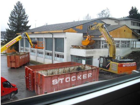
Die Ziegel des Daches werden entfernt, damit mit dem Abbruch des Daches begonnen werden kann. (7. März 2017)
