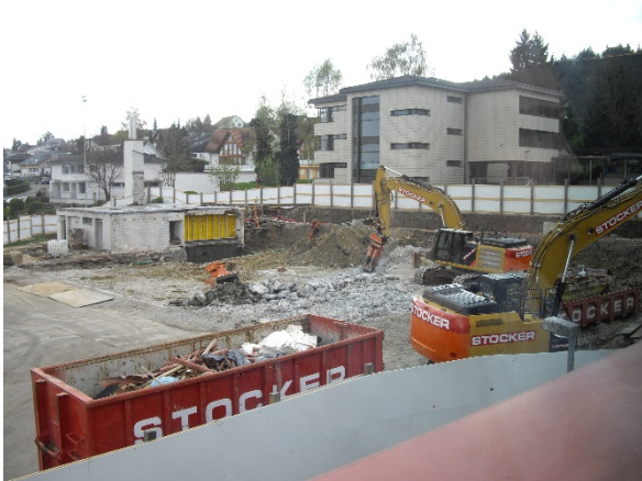
Nun werden die Bodenplatten demontiert. (4. April 2017)
