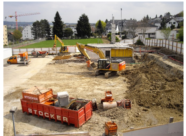
Die Aushubarbeiten der Bodenplatten ist abgeschlossen. Nun werden Ersatzmaterialien eingabaut um den Untergrund zu festigen. (10. April 2017)
