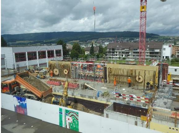
Die Trennwand zwischen der Turnhalle und des Mittagstischs wird vorbereitet. Aus diesen Kreisen welche an den Wänden zu sehen sind, werden später runde Fenster. (25. Juli 2017)
