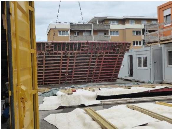
Die Matrizen wird für die Schalung der Wand hochgehoben und platziert. (14. September 2017)
