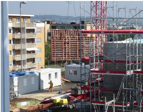
Die grosse Platte nennt man Matrize. Diese wird für die Schalung der Wände benötigt. (25. September 2017)
