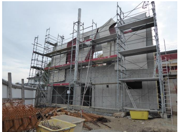
Die Fassade der Technik- und Schulräume sind bereits ausgeschalt. (26. September 2017)
